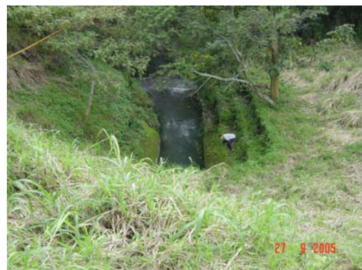
Fotografía 10. Panorámica del relleno y punto de captación aguas arriba.
