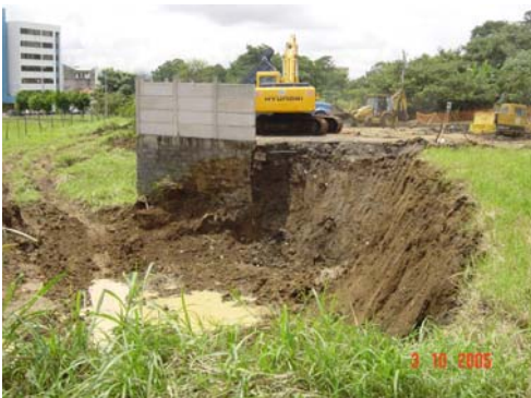
Fotografía 12. Proceso de excavación
