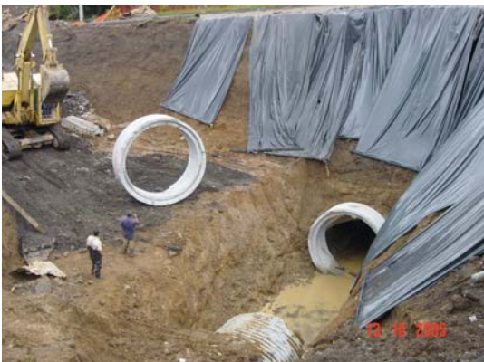
Fotografía 18. Instalación de la tubería
