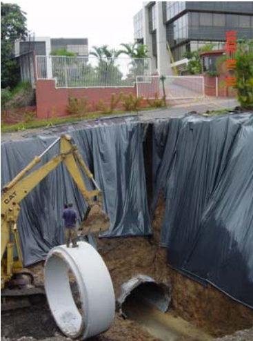
Fotografía 17. Instalación de la tubería
