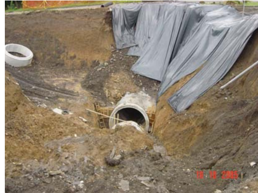
Fotografía 27. Trabajos de reconstrucción
