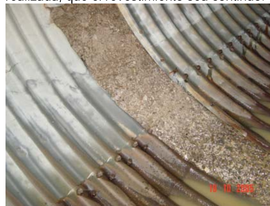
Fotografía 24. Punto de incremento en el diámetro de la tubería.
