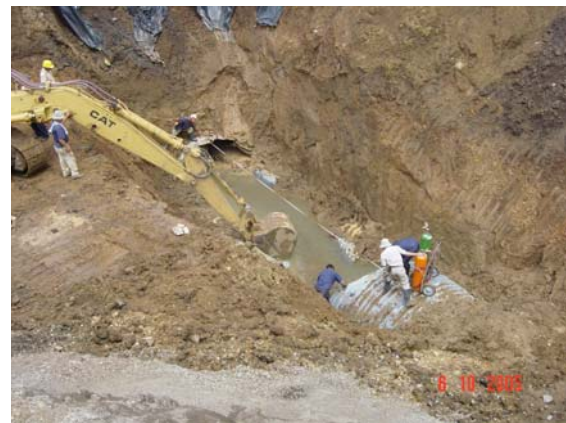
Fotografía 15. Medición del tramo crítico
