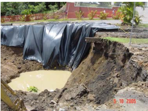
Fotografía 13. Proceso de excavación
