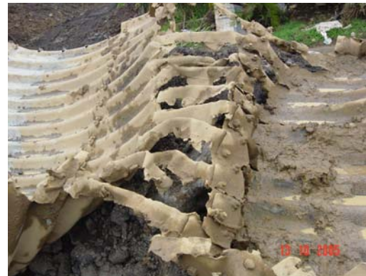
Fotografía 19. Tubería colapsada
