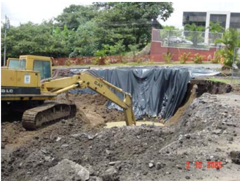
Fotografía 11. Proceso de excavación
